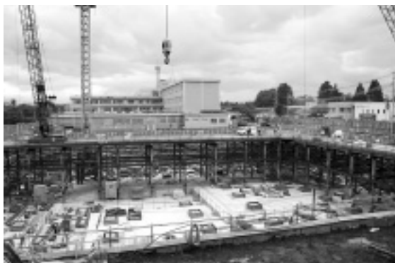
平成20年1月、完成予定の市立中央病院・新本館
