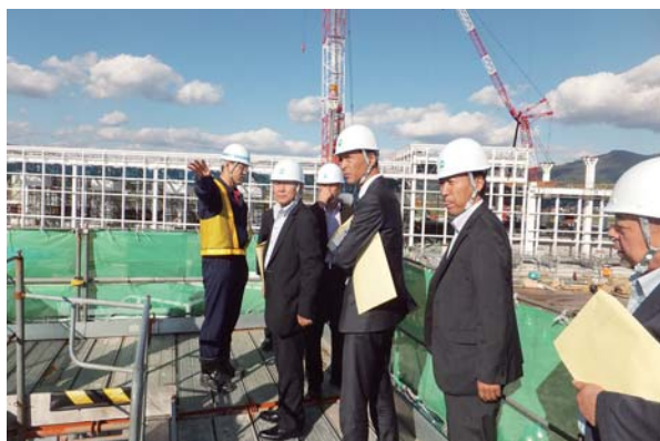
説明を聞きながら駅舎工事現場を視察
